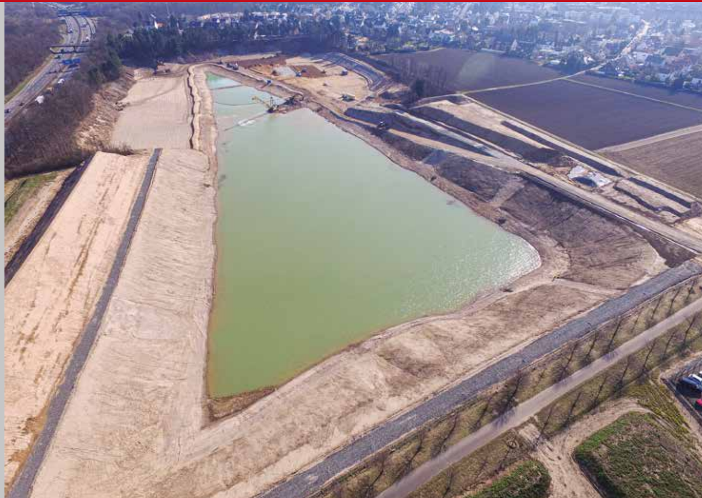
Blick auf die Seebaustelle Anfang März - ©AMAND Bau NRW, Ratingen
